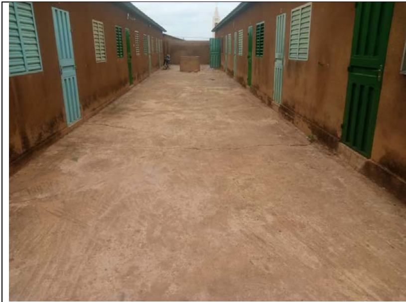
Photo 2 : Habitation de type moderne moyen mise en location à Affecia dans la ville de Glazoué.
